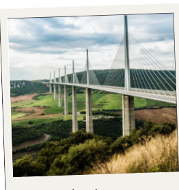
Viaduc de Millau
