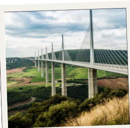
Viaduc de Millau
